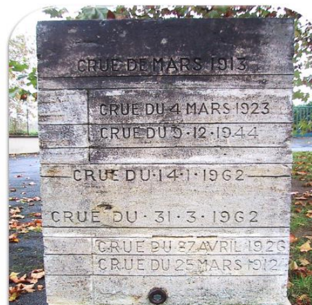
Echelle de crue – site de la Manu à Châtelleraut
